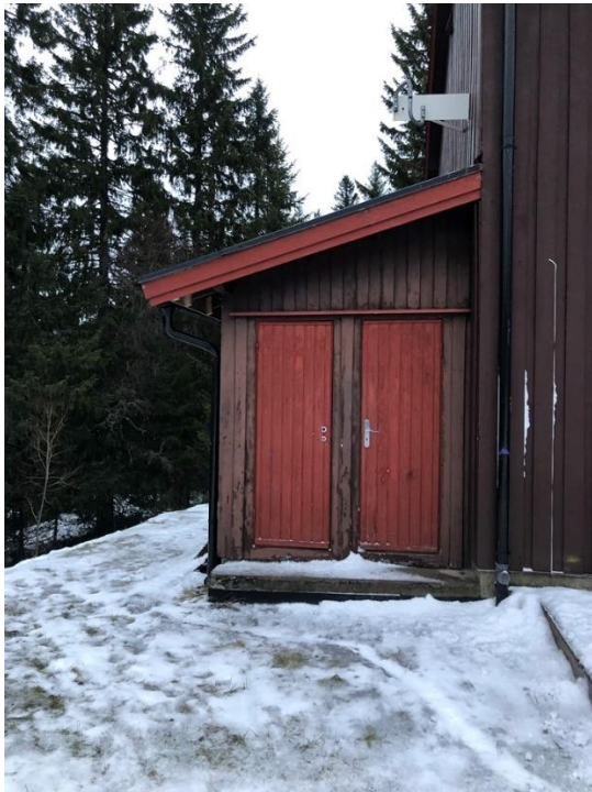
Rive alt i bod og bygg ny bod med 1 dør
